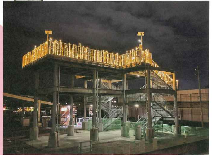
用宗漁港を照らす津波避難タワー
