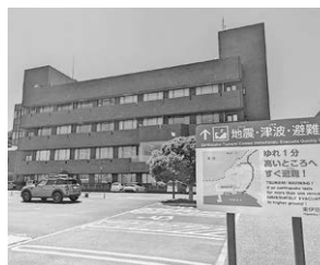
大津波発生時に電源喪失の危険性が高い役場庁舎
