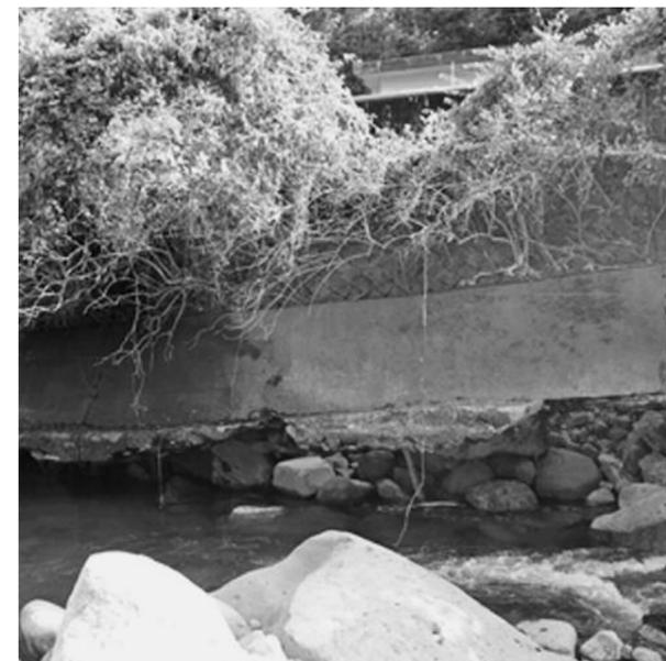
護岸のコンクリート部分が大きく損傷
