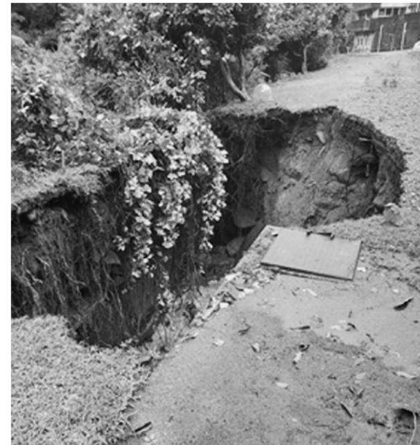
護岸が大きく削られて浄水場敷地の一部が陥没
