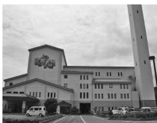
延命化工事が行われているエコクリーンセンター東河
