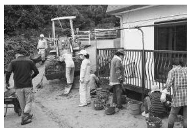
土砂撤去を行う災害ボランティア
