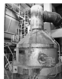
老朽化した し尿処理施設
