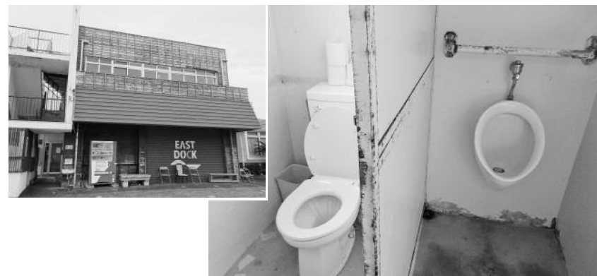
シェアオフィス（旧東海汽船事務所）の1階トイレ改修の意見も
