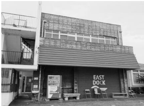
シェアオフィス（旧東海汽船事務所）改修により交流定住促進を
