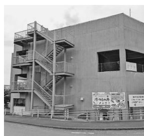
こらっしえ建設前に修繕された駐車場の外階段
