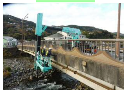
しらなみ橋(白田熱川線)
