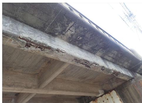
写真－2 主桁の鉄筋露出
