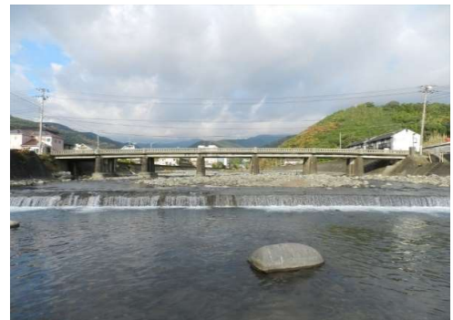
写真－1 白田川橋全景
