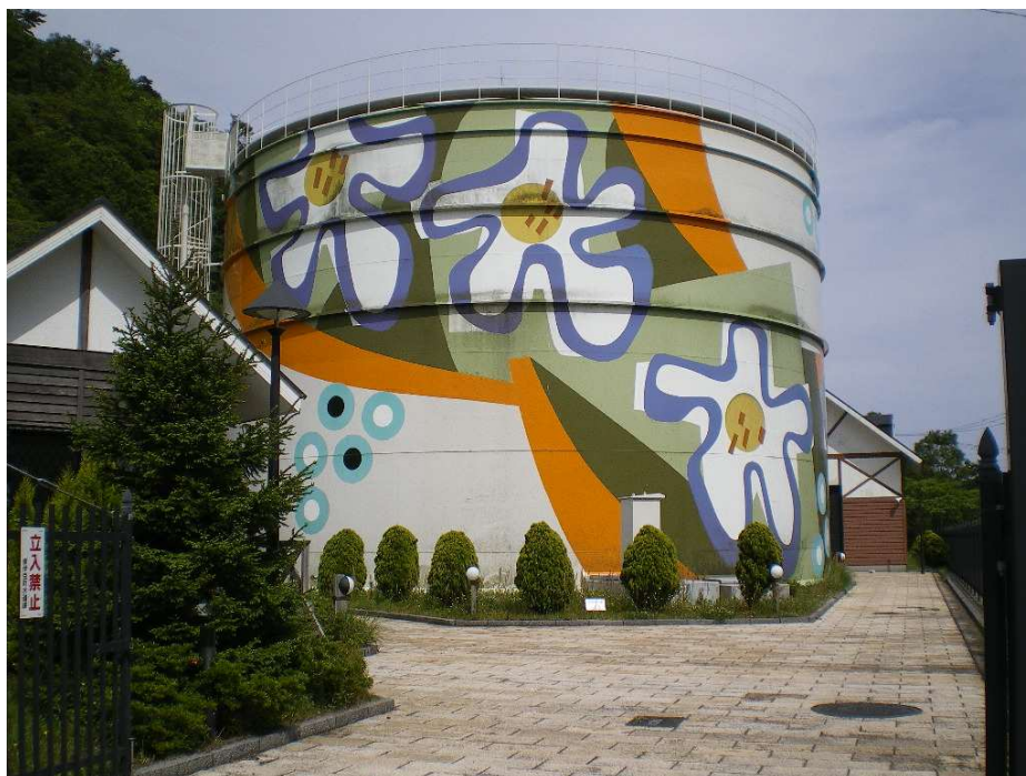
新稲取配水池
