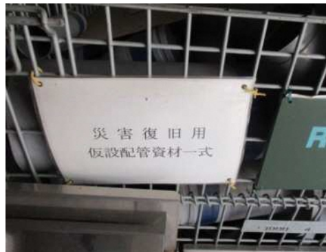
写真 3-11 応急復旧用資機材
