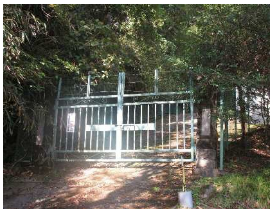
図 3-13 大川浄水場入口
